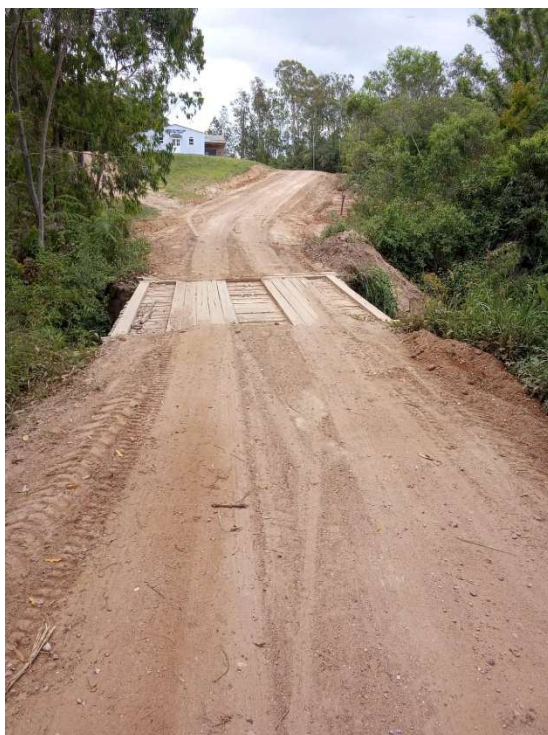
Foto do ponto de drenagem no ponto 10 - linha federal
